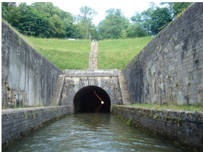
Zufahrt zum St-Albin-Tunnel
